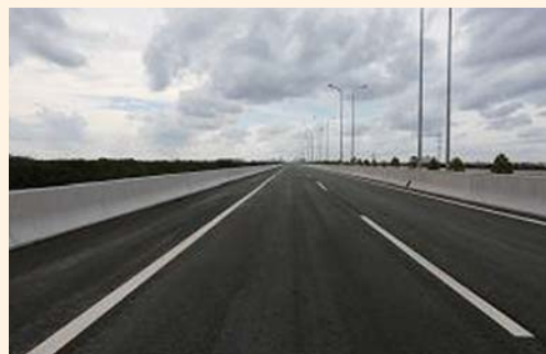
南北高速道路(ホーチミン-ゾーザイ間)にてITSが設置される 写真提供:高橋智史
