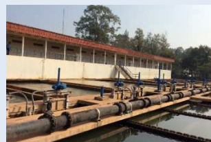
拡張予定の浄水場の様子 写真提供: JICA
