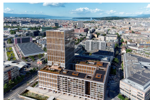
※ジュネーブのピクテ本社ビル
