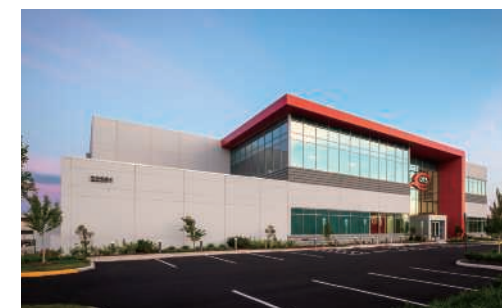
QTSデータセンター(バージニア州北部)
